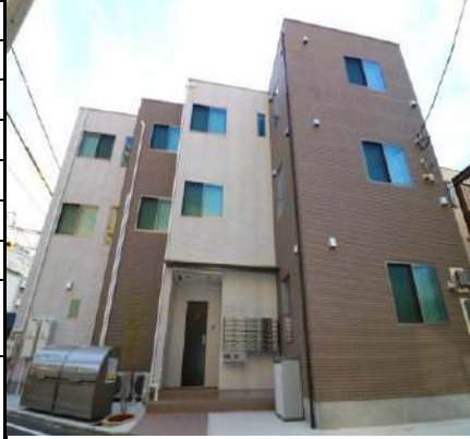
★物件的正東方向為鐵道， 所以圖面上靠右側的房間有加裝一道隔音窗。
